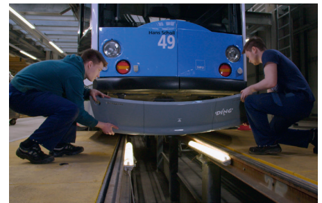
Montage der additiv gefertigten Kupplungsschürze
